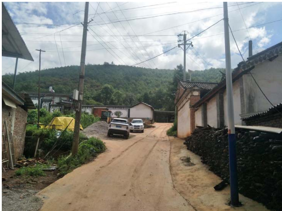
照片 7 村内无截排水沟
