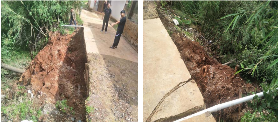
照片 3、4 滑坡后缘垮塌
